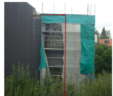
Une bâche arrachée a permis de découvrir la profondeur de la construction illégale.
