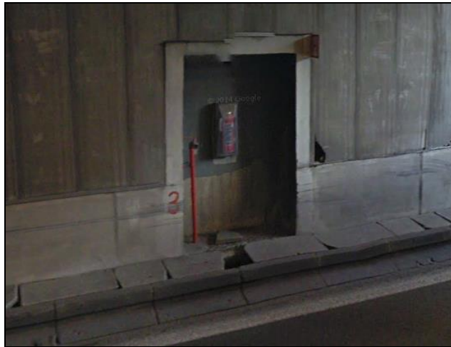
Figure 29 : Une des niches incendie du tunnel n°2 : Meiser → E40 (Source : Google Earth)
