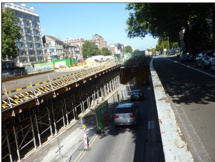
Photo 4 : Entrée du tunnel 6 Vergote/Montgomery → E40 (Agora - Septembre 2016)
