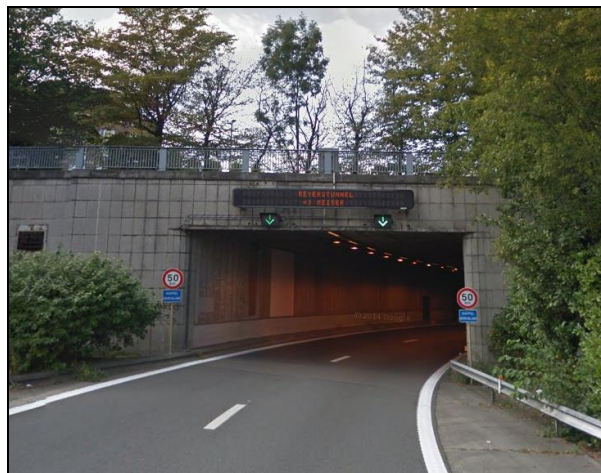
Figure 27 : Signalisation et PMV au droit de l'entrée du tunnel n°1 : E40 → MEISER 13 (Source : Google Street View)
