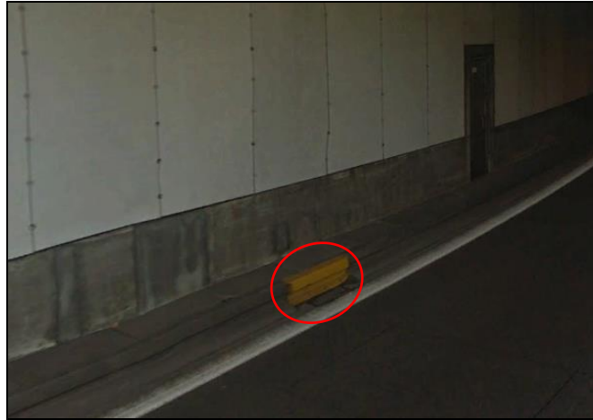
Figure 32 : Avaloir existant dans le tunnel n°5 (E40 → Vergote/Montgomery, côté E40) (Source : Google Earth)
