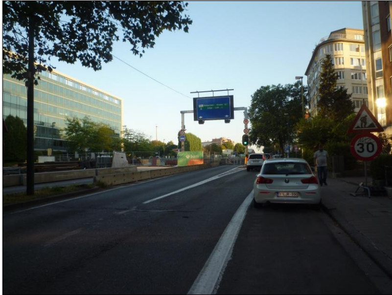
Photo 2 : Entrée du tunnel 2 Meiser → E40 (Agora - Septembre 2016)
