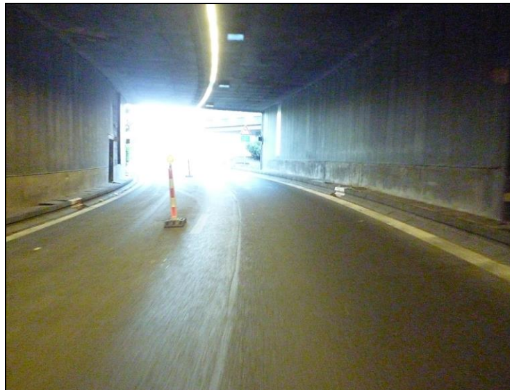
Photo 5 : Circulation sur une bande au niveau du tunnel n°2 en direction de l'E40 depuis Meiser (Agora - Septembre 2016)
