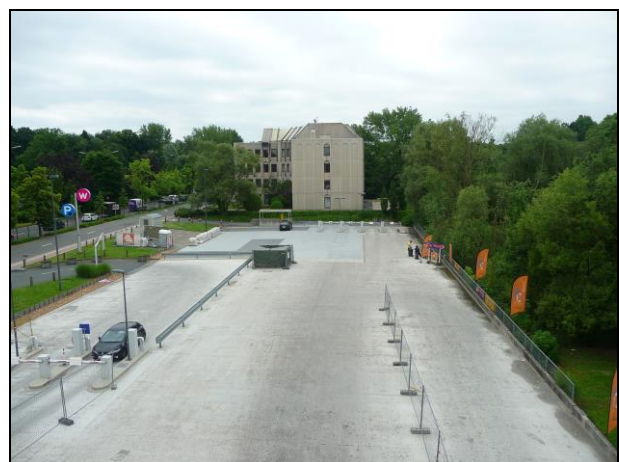
Vue de la zone Deck parking
