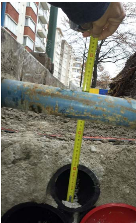
La profondeur d'enfouissement est à certains endroits bien inférieure à ce qui est annoncé.
