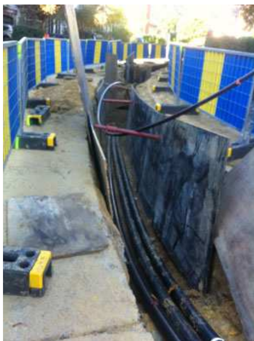
Installation du câble au square Vergote
