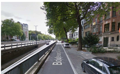
Vue de la latérale du boulevard Reyers vers Montgomery à côté de la trémie.
