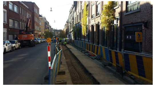
Pose du câble dans la rue Pelletier, en novembre 2015.
