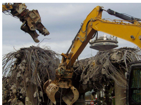
Démolition du Viaduc Reyers en novembre 2015.
