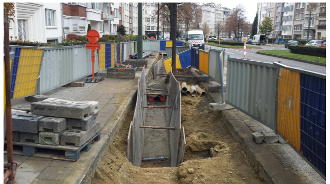
Pose du câble dans l'avenue de Broqueville
