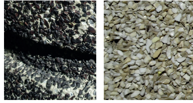
Détails de la Villa Rive 77:
