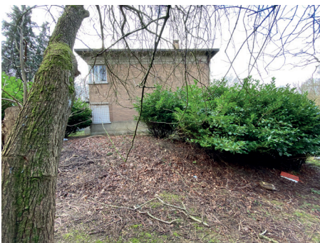
Reportage photographique des façades
